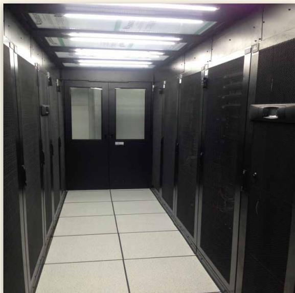
空调方面，采用6组5匹吸顶式空调及2套机房专用空调组成，常年确保机房温度控制在23度以内。托管机房可以为学院及部门提供服务器托管服务。消防系统方面，中心机房配备火灾预警及消防设施。中心机房门口还设有门禁系统及监控设备，避免无关人员随意进入中心机房设备区域。
